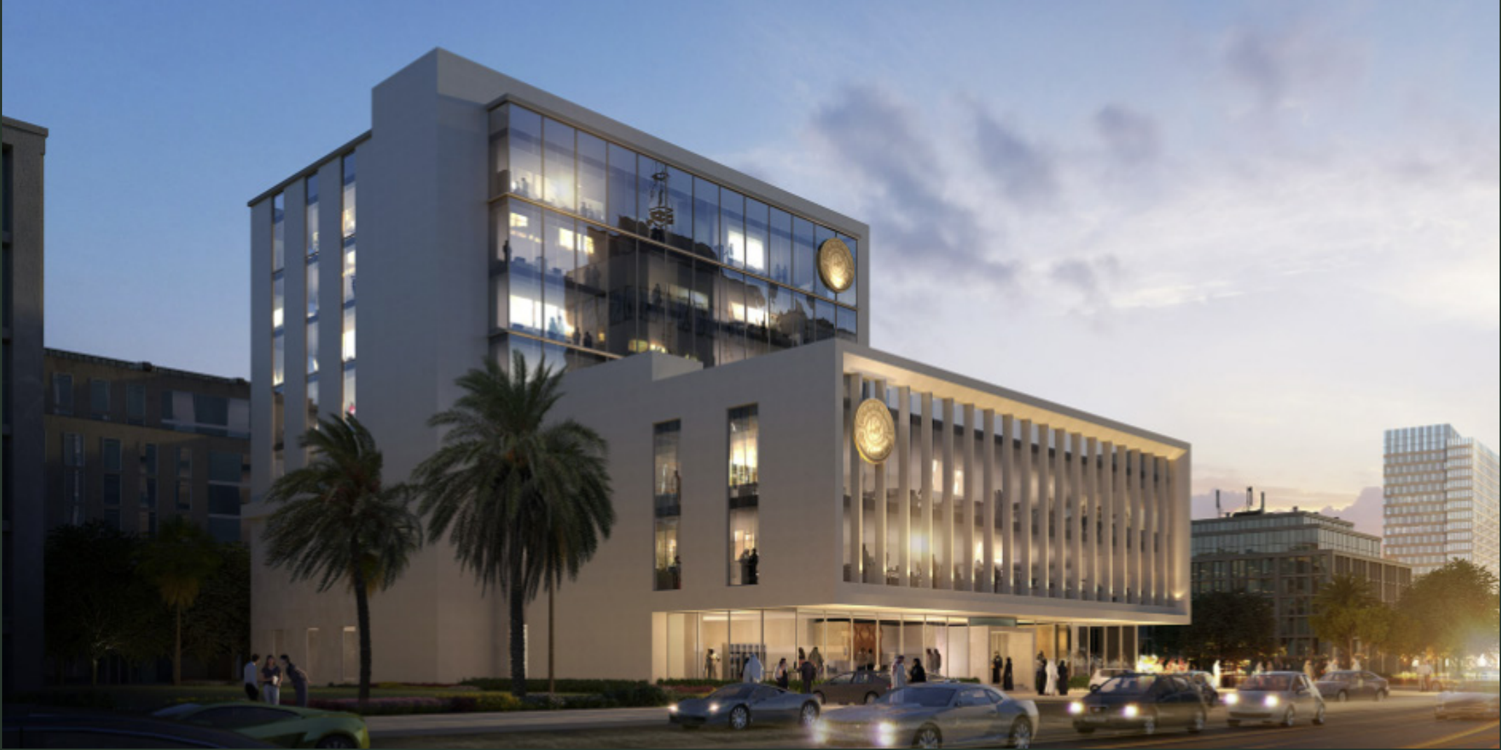
مركز بيانات مصرف قطر المركزي (٤ طوابق سفلية + أرضي + ٧ طوابق)
